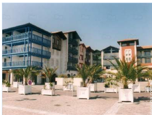
widok od północnego zachodu
