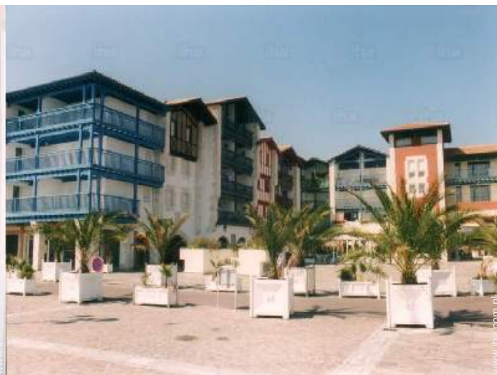
widok od północnego zachodu
