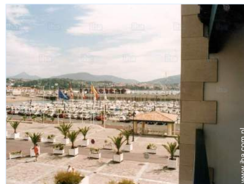
widok od południowego zachodu
