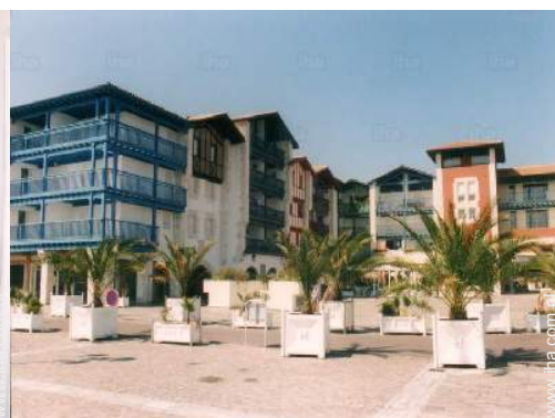
widok od północnego zachodu
