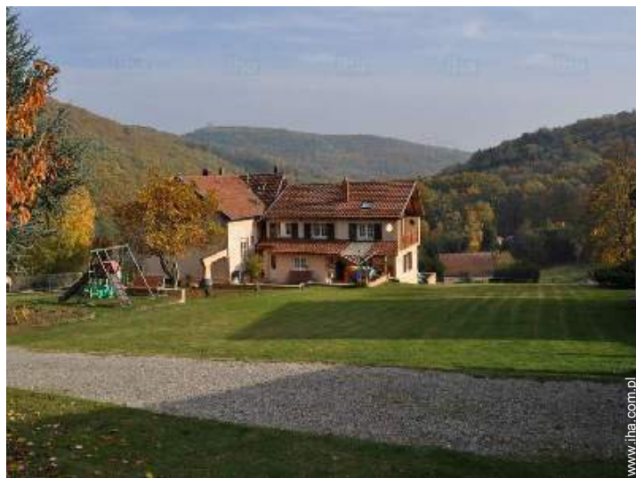
widok od południowego zachodu
