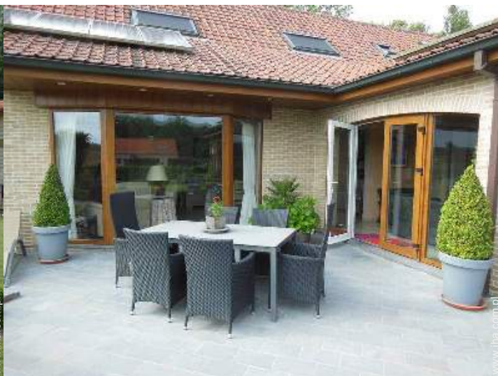
Zainstalowane na zewnątrz objekty
